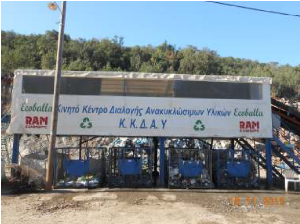
Ταινία χειροδιαλογής ανακυκλώσιμων υλικών (ΚΔΑΥ2)
