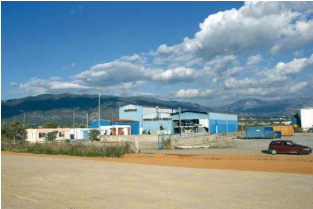
Μονάδα ανακύκλωσης και λιπασματοποίησης απορριμμάτων Καλαμάτας (ΜΟΛΑΚ)
