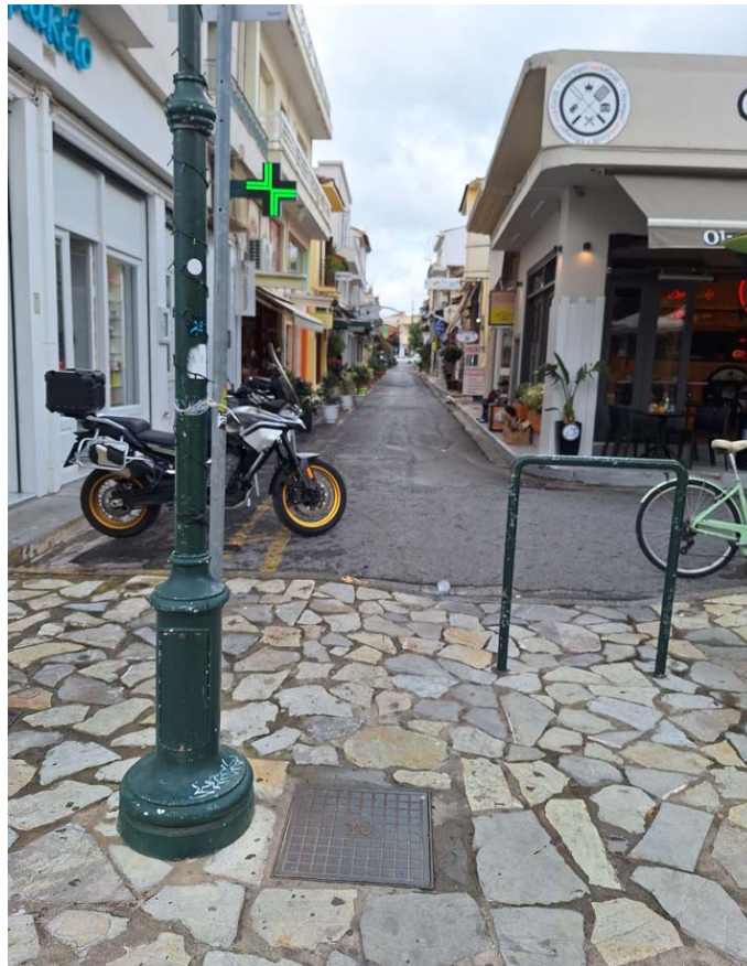
Εικόνα 3.4 Ύπαρξη εμποδίου (κιγκλιδώματος) στην όδευση από την οδό Αιύτου προς την πλατεία 23 ης Μαρτίου
