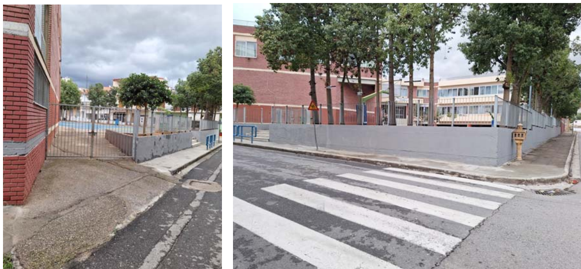
Εικόνα 3.27 Διάβαση Καλλιπάτειρας, 1 ο Δημοτικό Σχολείο Καλαμάτας
