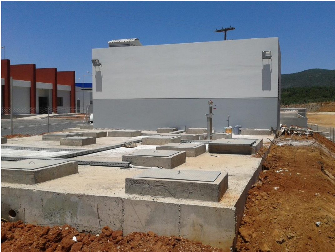
Εικόνα 1: Εξωτερική άποψη της Μονάδας
