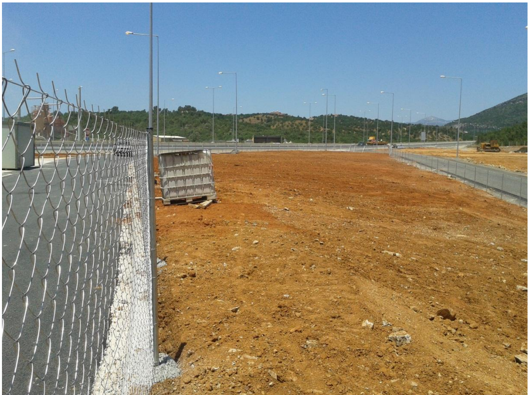
Εικόνα 2: Περιοχή άρδευσης με περίφραξη (Βόρεια)
