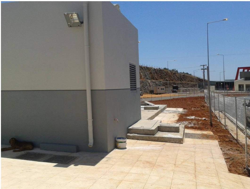
Εικόνα 4: Εξωτερική άποψη της Μονάδας
