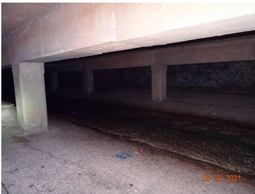
Εικόνα 14.45: Καλυμμένο τμήμα κοίτης π. Νέδοντα που ανακατασκευάζεται (~Χ.Θ. 2+290).
