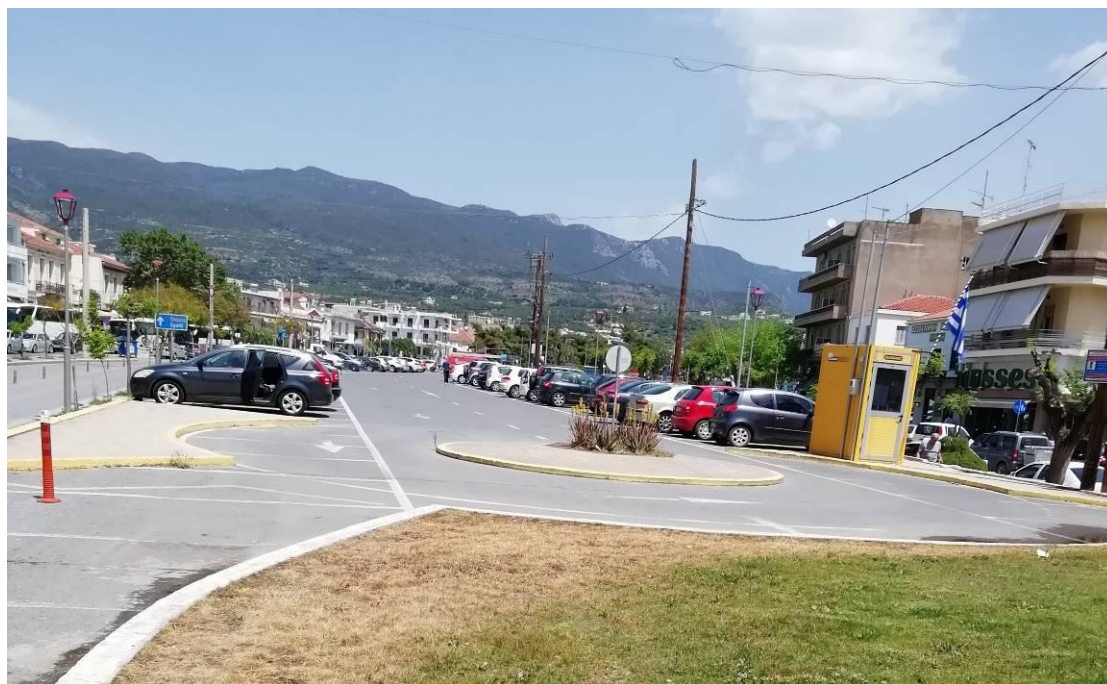
Εικόνα 14.47: Καλυμμένο τμήμα κοίτης π. Νέδοντα που διατηρείται, από ύψος οδού 23 ης Μαρτίου (~Χ.Θ. 2+325). Έχει διαμορφωθεί σε υπαίθριο Δημοτικό χώρο στάθμευσης. Θέα προς τα ανάντη.
