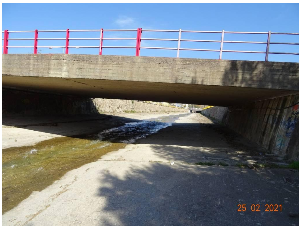
Εικόνα 14.31: Γέφυρα οδού Περικλέους (~Χ.Θ. 1+500).
