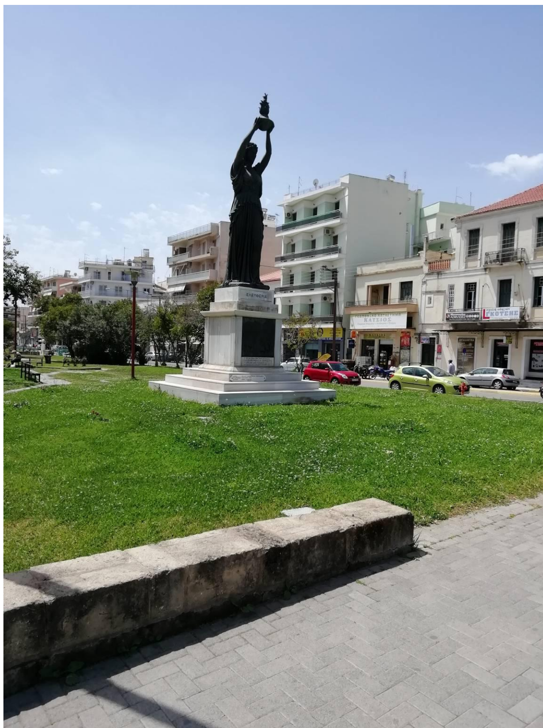
Εικόνα 14.46: Πέρασ καλυμμένου τμήματος κοίτης π. Νέδοντα που ανακατασκευάζεται, από ύψος οδού 23 ης Μαρτίου (~Χ.Θ. 2+300). Θέα προς τα κατάντη.
