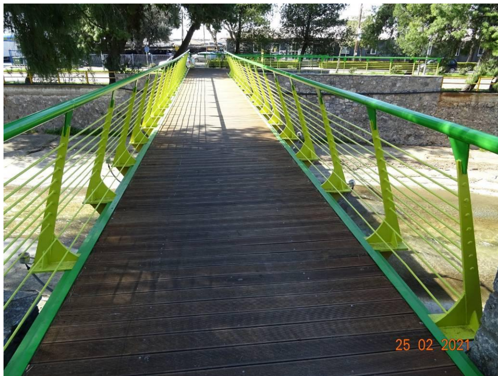
Εικόνα 14.27: Υφιστάμενη πεζογέφυρα (~Χ.Θ. 1+140).
