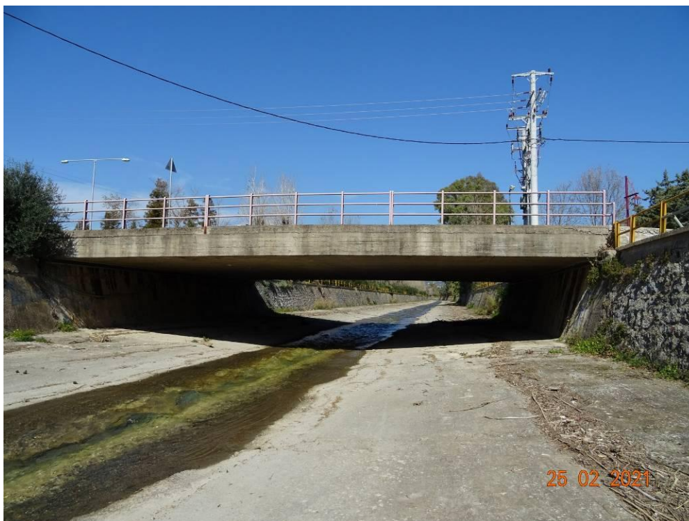
Εικόνα 14.19: Γέφυρα οδού Λυκούργου (~Χ.Θ. 0+380).
