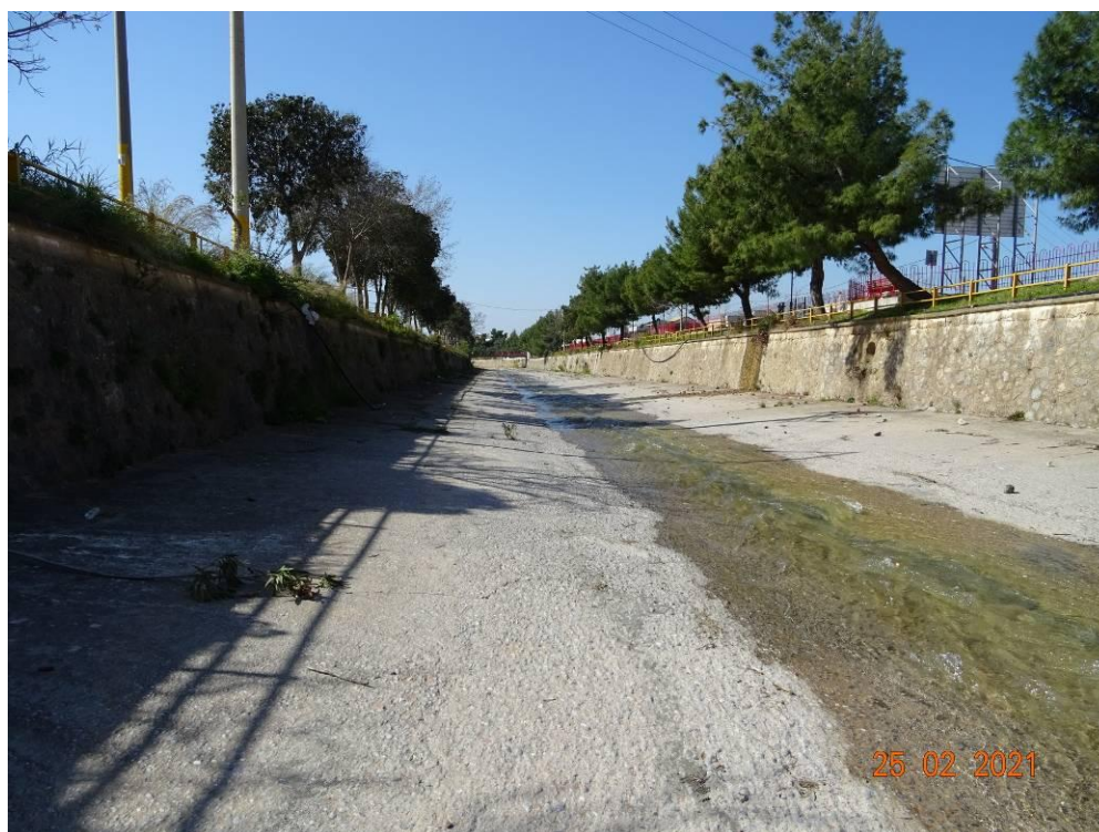
Εικόνα 14.64: Άποψη υφιστάμενης διευθετημένης κοίτης π. Νέδοντα από την γέφυρα της οδού Σπάρτης (~Χ.Θ. 3+175). Θέα προς τα κατάντη.
