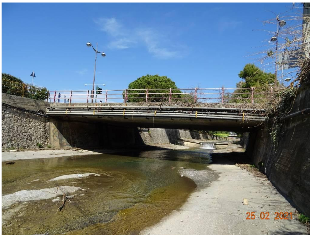
Εικόνα 14.24: Γέφυρα οδού Μακεδονίας (~Χ.Θ. 1+000).
