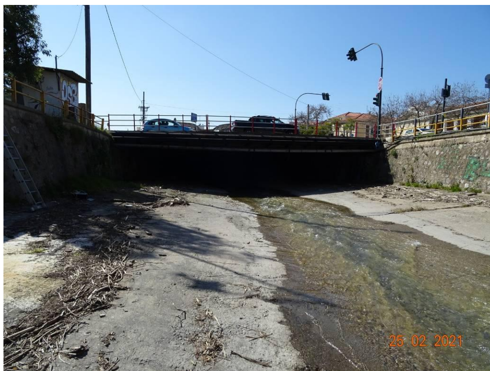
Εικόνα 14.52: Γέφυρα της οδού Λεϊκών (~Χ.Θ. 2+500). Θέα προς τα κατάντη.
