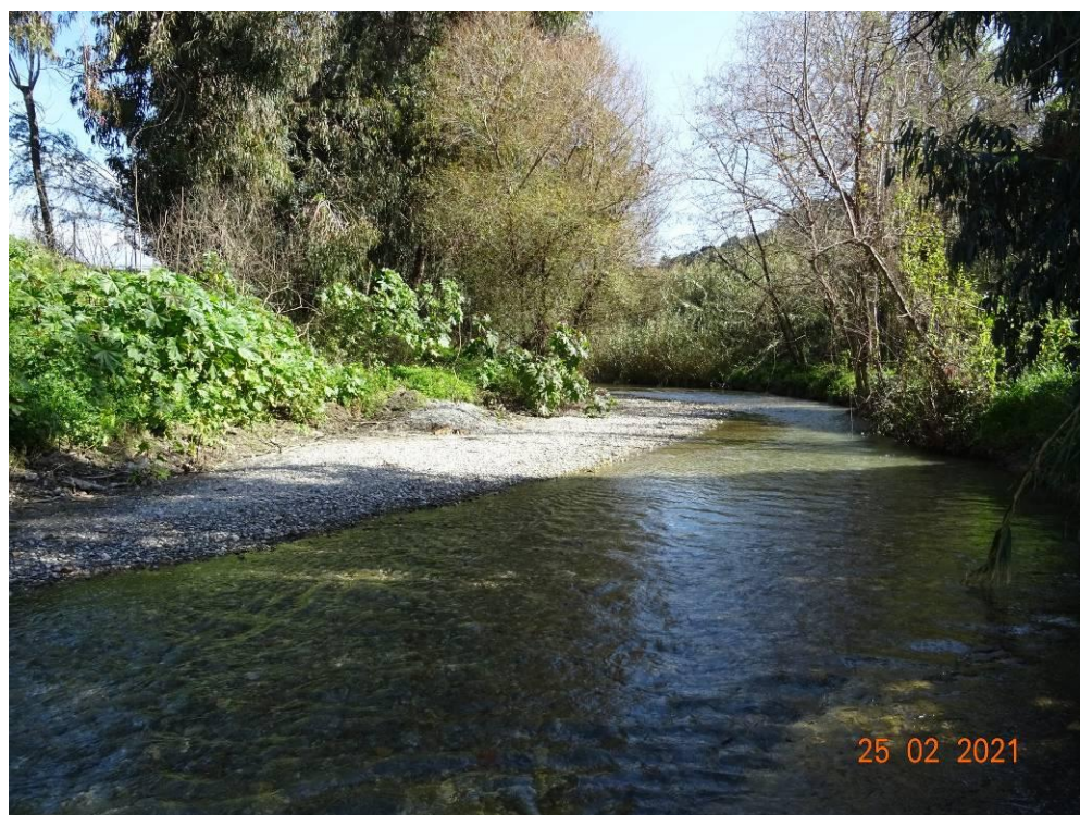
Εικόνα 14.67: Άποψη κοίτης π. Νέδοντα, ανάντη του τέλους της υφιστάμενης διευθέτησης και προτεινόμενων έργων αναδιευθέτησης της κοίτης (~Χ.Θ. 3+200). Θέα προς τα ανάντη.
