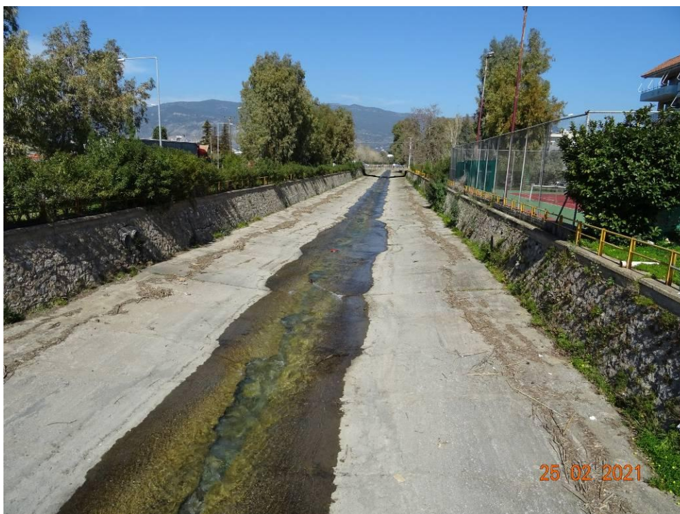
Εικόνα 14.18: Άποψη υφιστάμενης διευθετημένης κοίτης π. Νέδοντα, από γέφυρα οδού Ευαγγελιστρίας (~Χ.Θ. 0+200). Θέα προς τα ανάντη.
