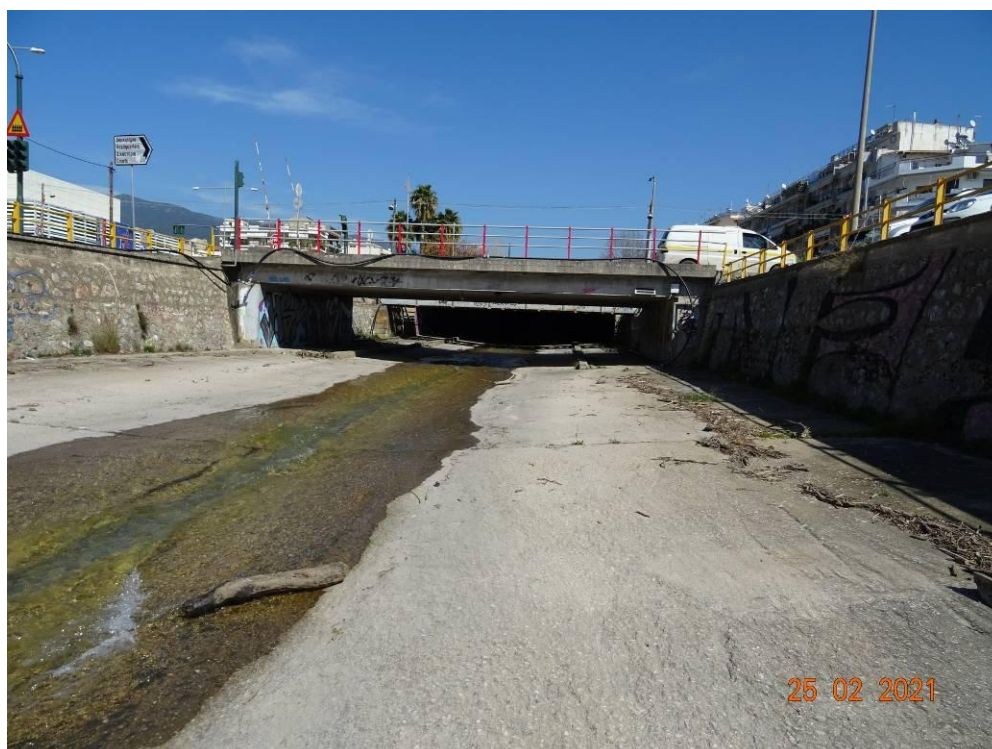
Εικόνα 14.34: Γέφυρα οδού Ύδρας / Παλαμά (~Χ.Θ. 1+700).
