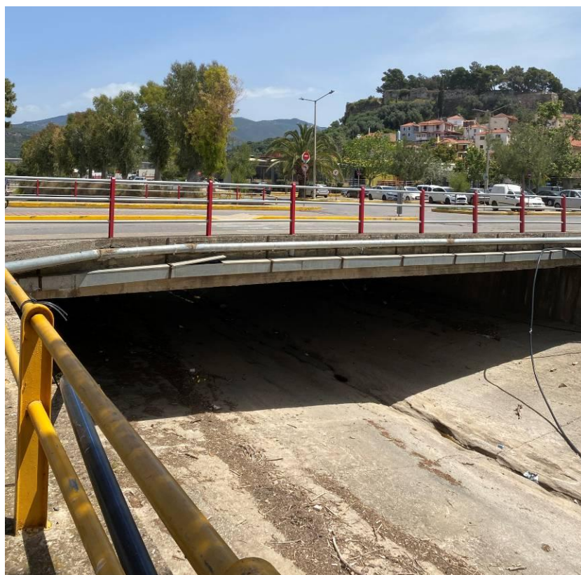
Εικόνα 14.56: Γέφυρα οδού Αγοράς (~Χ.Θ. 2+680).
