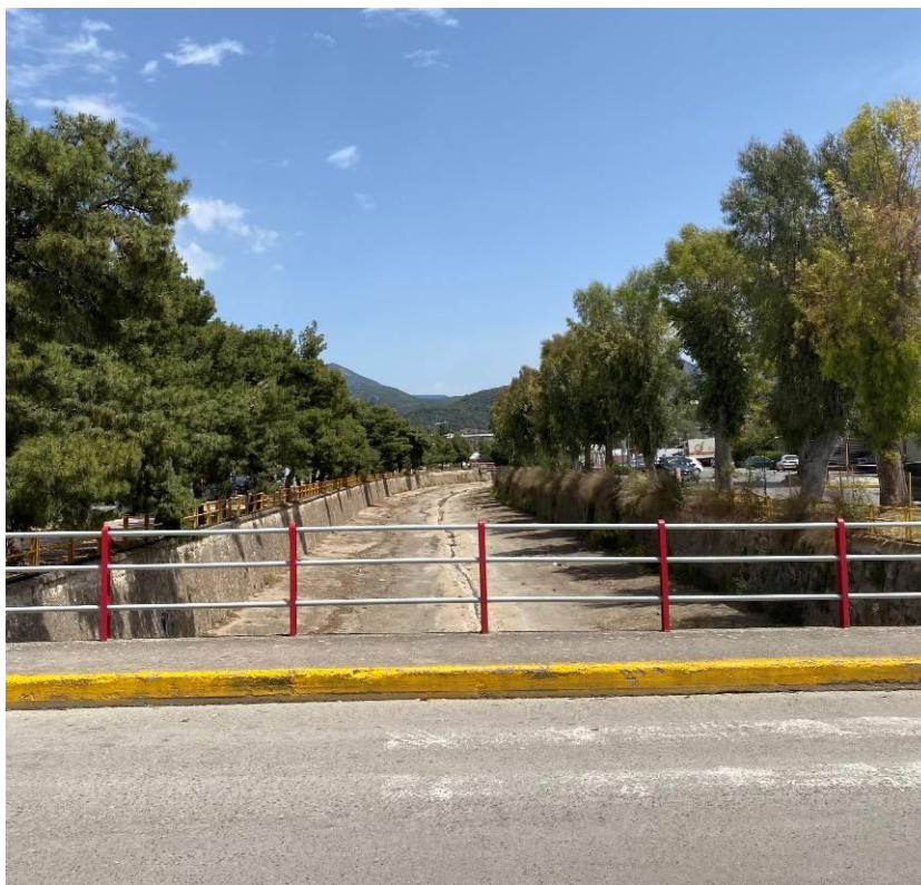
Εικόνα 14.57: Άποψη υφιστάμενης διευθετημένης κοίτης π. Νέδοντα από την γέφυρα της οδού Αγοράς (~Χ.Θ. 2+650). Θέα προς τα ανάντη.
