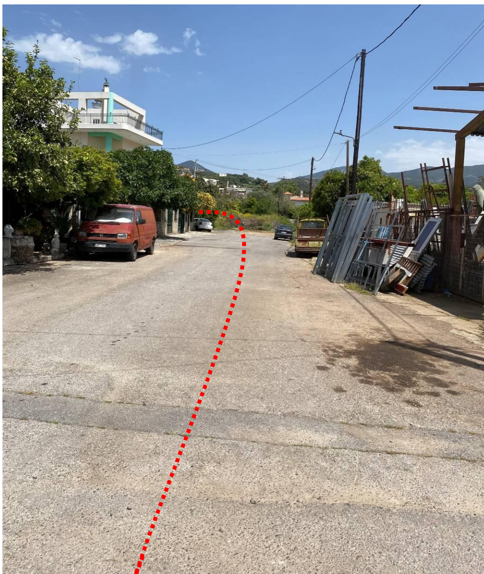
Εικόνα 14.9: Περιοχή διέλευσης προβλεπόμενου έργου διευθέτησης ρ. Καραμπογιά (~Χ.Θ. 0+300). Θέα προς τα ανάντη.
