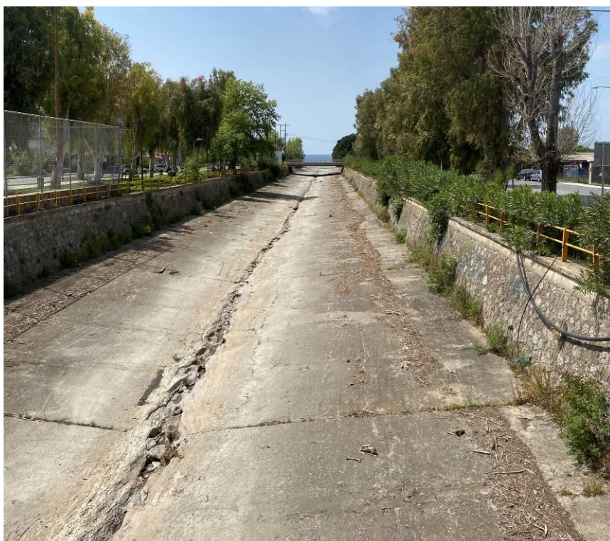
Εικόνα 14.21: Άποψη υφιστάμενης διευθετημένης κοίτης π. Νέδοντα, από γέφυρα οδού Λυκούργου (~Χ.Θ. 0+380). Θέα προς τα κατάντη.
