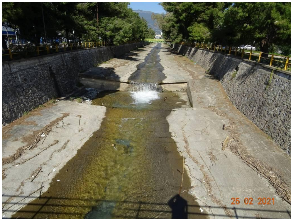
Εικόνα 14.26: Αποψη υφιστάμενης διευθετημένης κοίτης π. Νέδοντα, από γέφυρα οδού Μακεδονίας (~Χ.Θ. 1+000). Διακρίνεται υφιστάμενο αναβαθμός. Θέα προς τα ανάντη.
