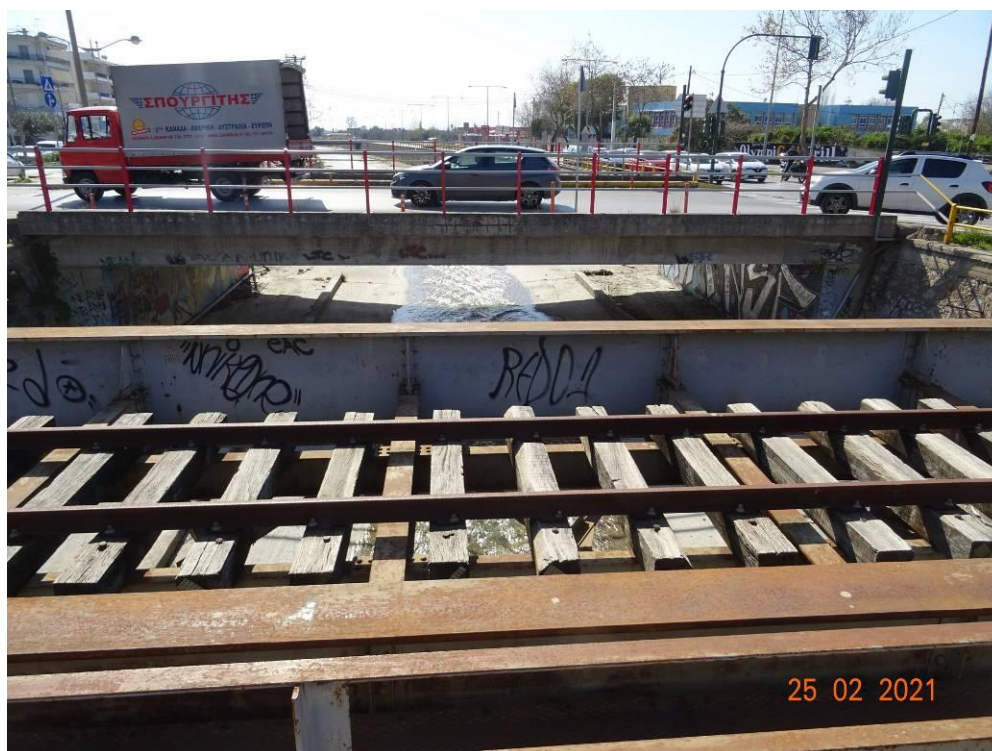
Εικόνα 14.36: Σιδηροδρομική γέφυρα (~Χ.Θ. 1+720), πλησίον γέφυρας οδού Παλαμά. Θέα προς τα κατάντη.
