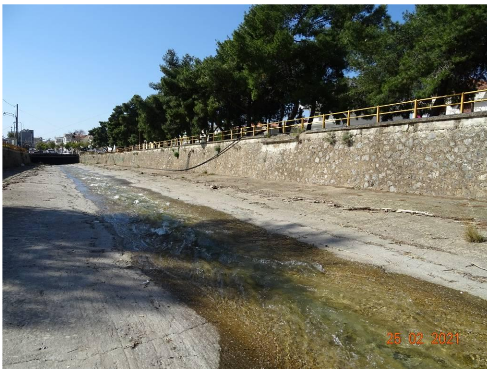
Εικόνα 14.54: Άποψη υφιστάμενης διευθετημένης κοίτης π. Νέδοντα (~Χ.Θ. 2+650). Θέα προς τα κατάντη.
