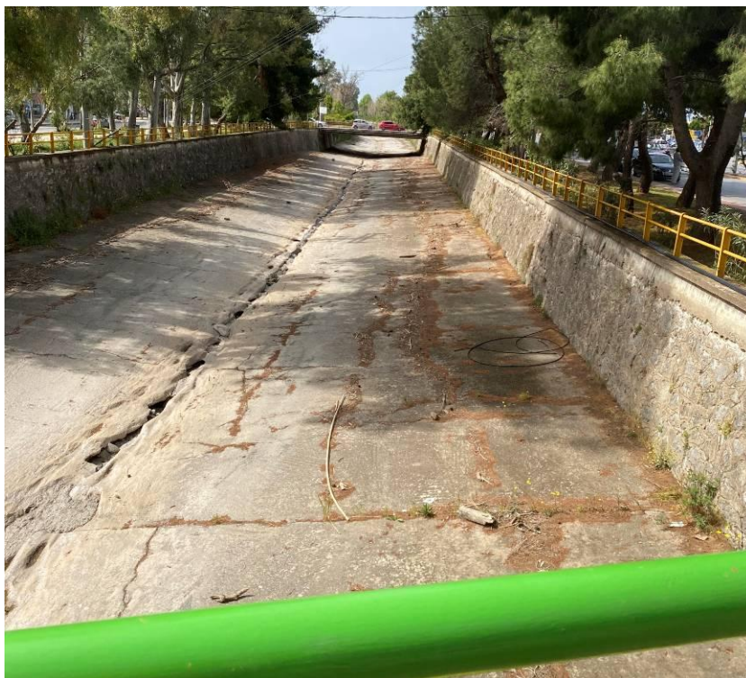
Εικόνα 14.28: Άποψη διευθετημένης κοίτης π. Νέδοντα από την υφιστάμενη πεζογέφυρα (~Χ.Θ. 1+140). Στο βάθος διακρίνεται η γέφυρα της οδού Μακεδονίας. Θέα προς τα κατάντη.
