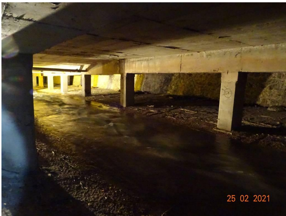
Εικόνα 14.44: Καλυμμένο τμήμα κοίτης π. Νέδοντα που ανακατασκευάζεται (~Χ.Θ. 2+200).
