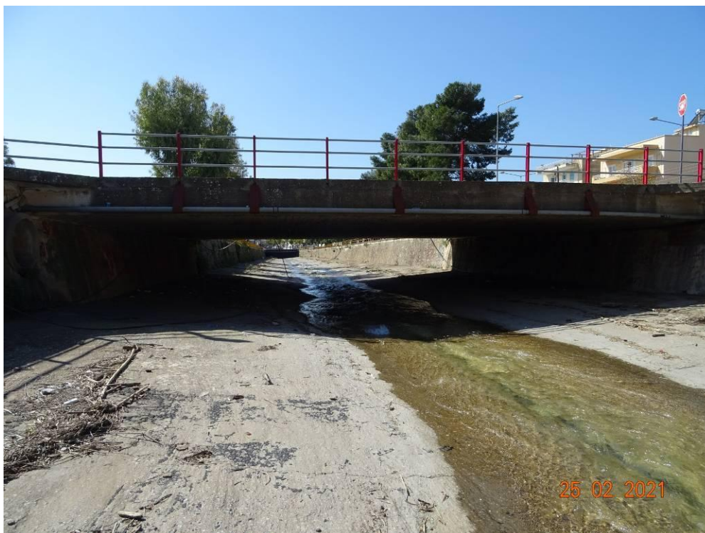
Εικόνα 14.17: Γέφυρα οδού Ευαγγελιστρίας (~Χ.Θ. 0+200).
