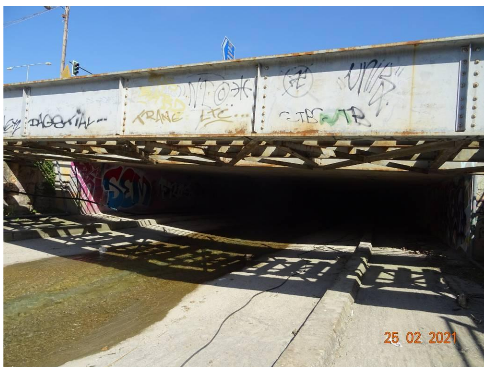
Εικόνα 14.35: Σιδηροδρομική γέφυρα (~Χ.Θ. 1+720), πλησίον γέφυρας οδού Παλαμά. Θέα προς τα κατάντη.
