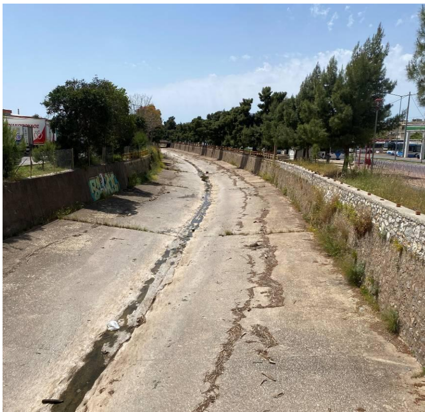
Εικόνα 14.59: Άποψη υφιστάμενης διευθετημένης κοίτης π. Νέδοντα από την υφιστάμενη πεζογέφυρα (~Χ.Θ. 2+940). Θέα προς τα κατάντη.
