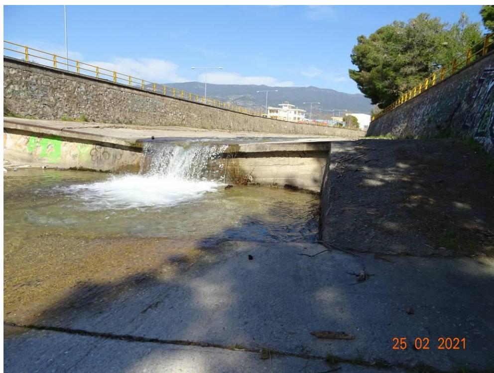
Εικόνα 14.30: Άποψη υφιστάμενου αναβαθμού επί της διευθετημένης κοίτης π. Νέδοντα (~Χ.Θ. 1+360). Θέα προς τα ανάντη.
