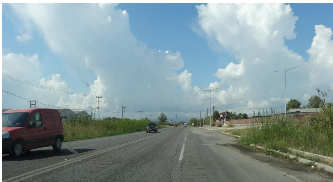
Φωτογραφία 14.6: Άποψη της υφιστάμενης οδού στην περιοχή της ΒΙ.ΠΕ. στη Χ.Θ. 2+800.
