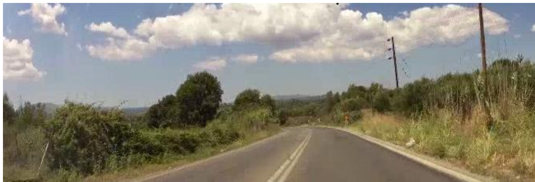
Φωτογραφία 10.17: Άποψη της υφιστάμενης αρτηρίας και της ευρύτερης περιοχής μελέτης προς δύση (Χ.Θ. 12+250)
