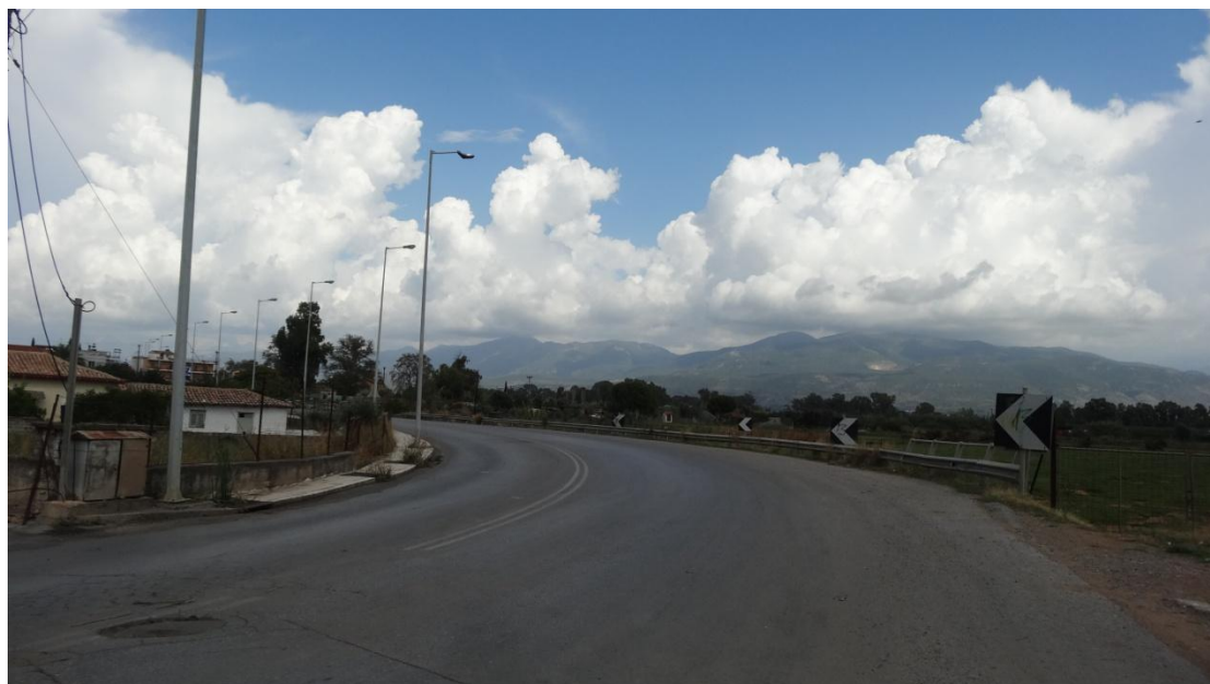
Φωτογραφία 14.13: Άποψη της υφιστάμενης οδού στη Χ.Θ. 10+000.
