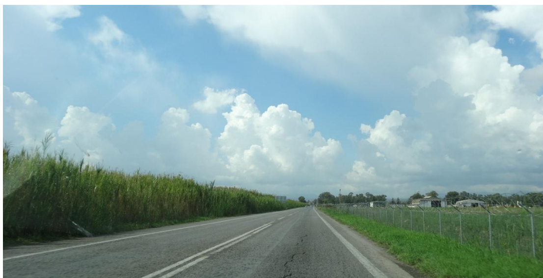
Φωτογραφία 14.8: Άποψη της υφιστάμενης οδού από το Αεροδρόμιο προς Μεσσήνη στη Χ.Θ. 5+200.
