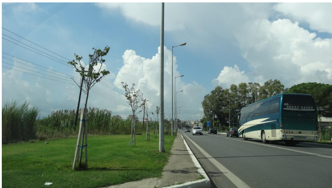
Φωτογραφία 14.9: Άποψη της υφιστάμενης οδού στον κόμβο της Μεσσήνης (Χ.Θ. 5+500).
