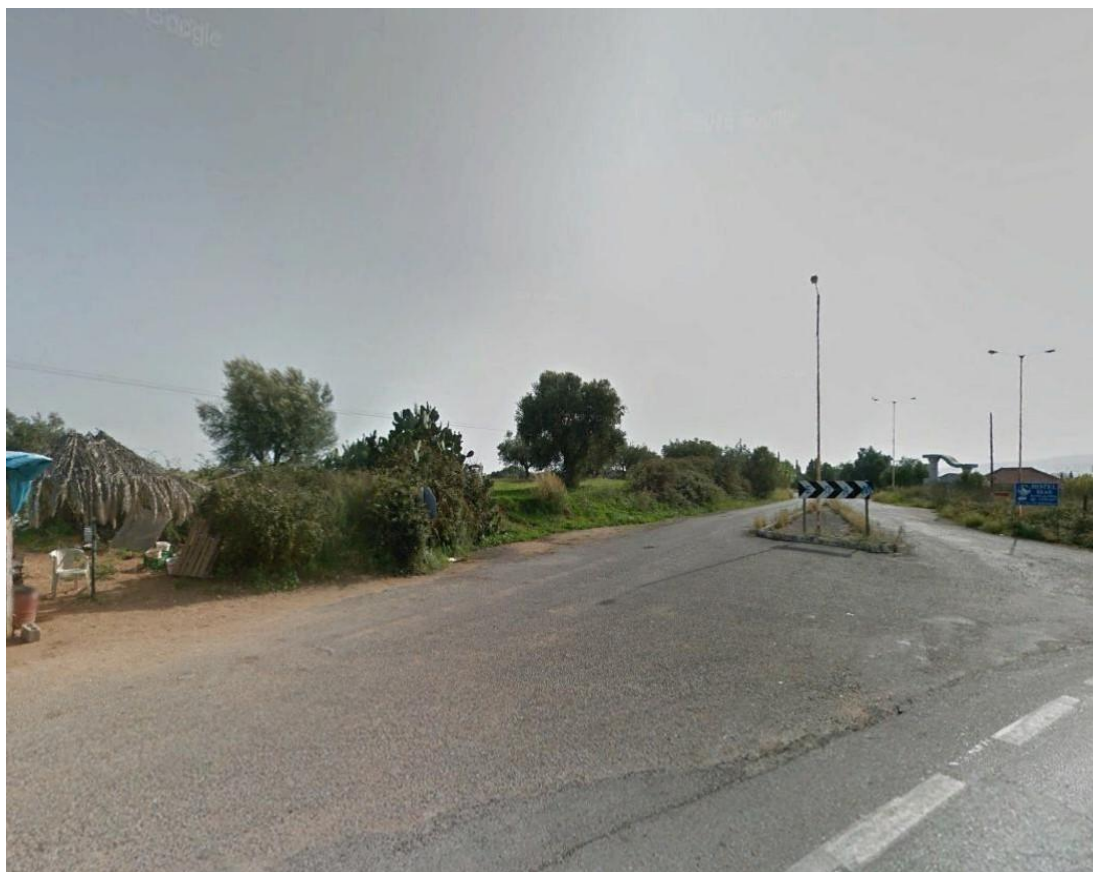
Φωτογραφία 14.15: Άποψη του σημείου που θα δημιουργηθεί ο κόμβος Ανάληψης προς νότο (Χ.Θ. 11+750).
