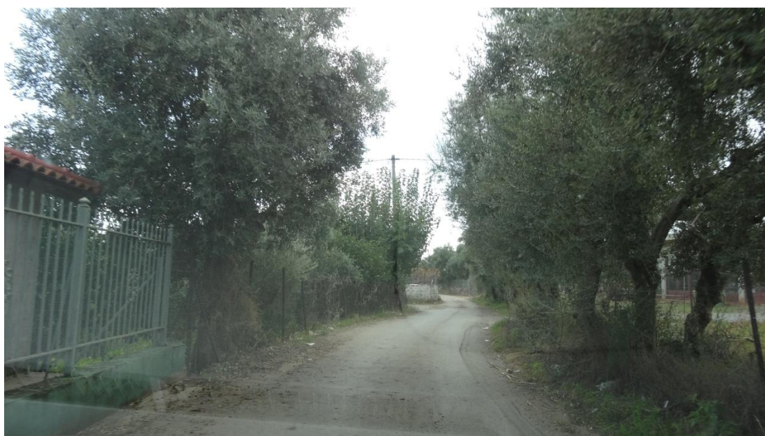
Φωτογραφία 14.10: Άποψη της ευρύτερης περιοχής στη Χ.Θ. 6+600.
