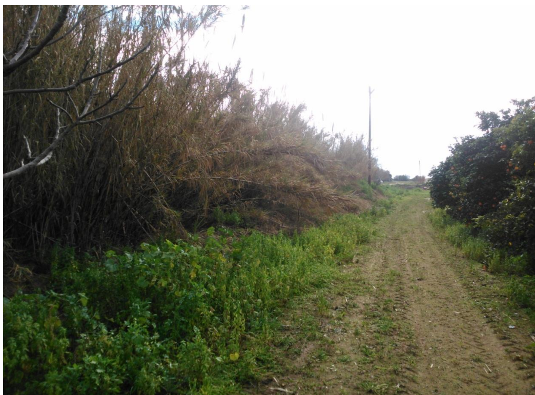
Φωτογραφία 14.20: Άποψη της ευρύτερης περιοχής μελέτης προς νότο (Χ.Θ. 15+900).
