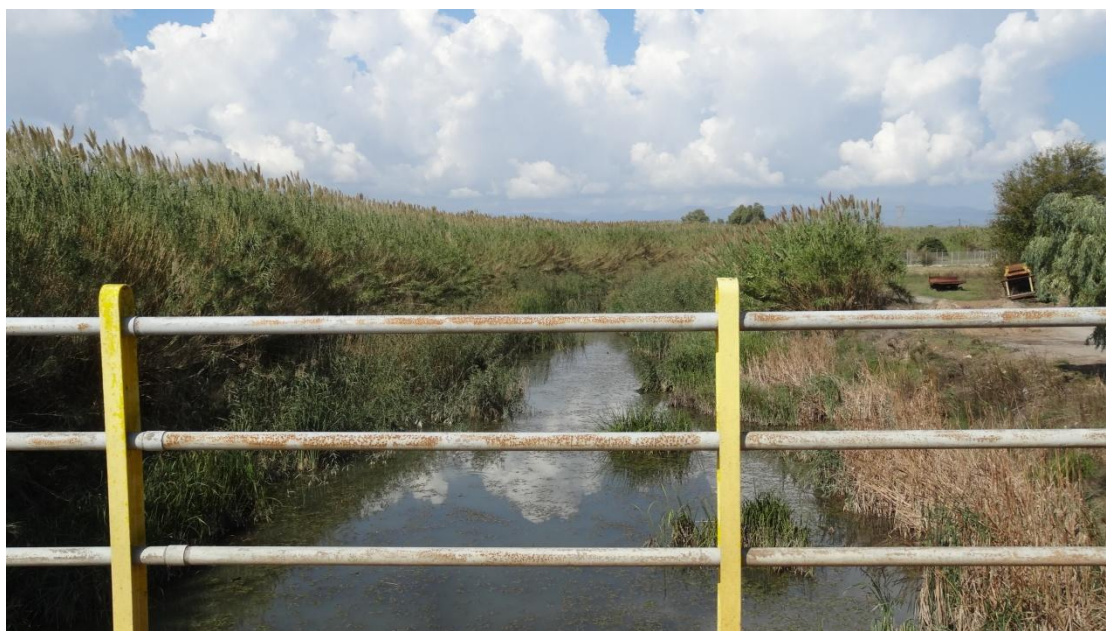
Φωτογραφία 14.3: Άποψη του Άρι Ποταμού από τη Χ.Θ. 0+850 της υφιστάμενης αρτηρίας.
