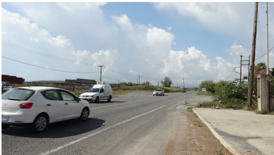
Φωτογραφία 14.7: Άποψη της υφιστάμενης οδού στην περιοχή της ΒΙ.ΠΕ. στη Χ.Θ. 3+800.
