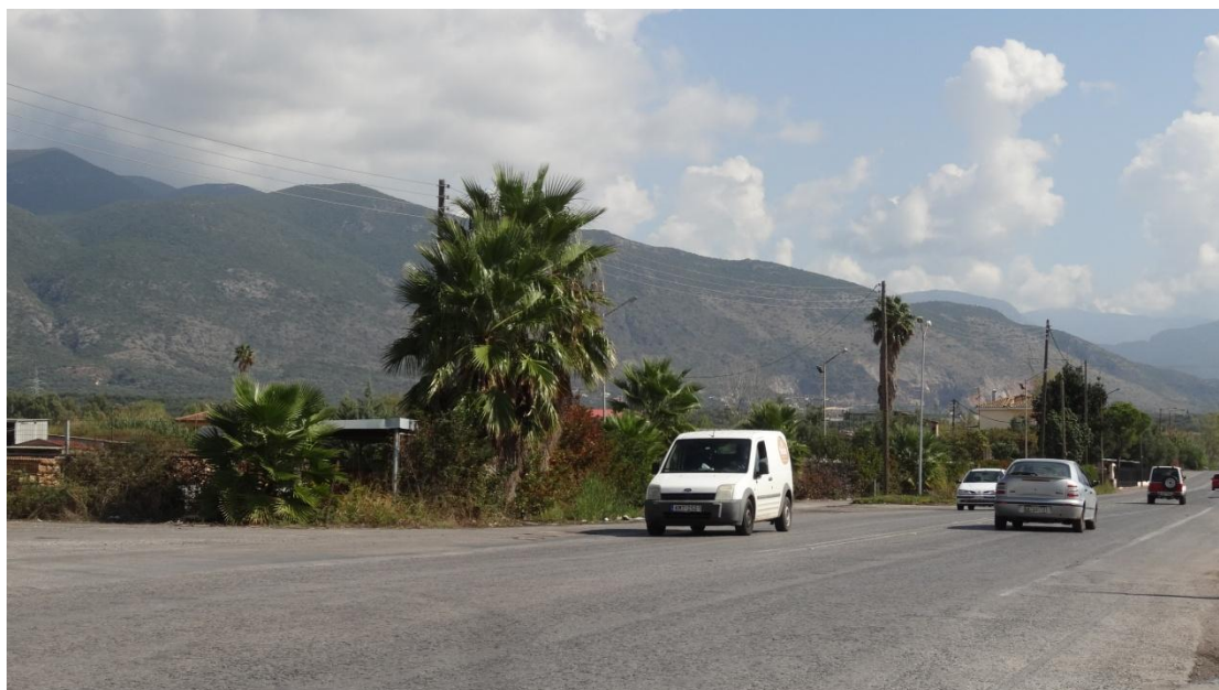
Φωτογραφία 14.5: Άποψη της υφιστάμενης οδού στην περιοχή της ΒΙ.ΠΕ. στη Χ.Θ. 2+600.
