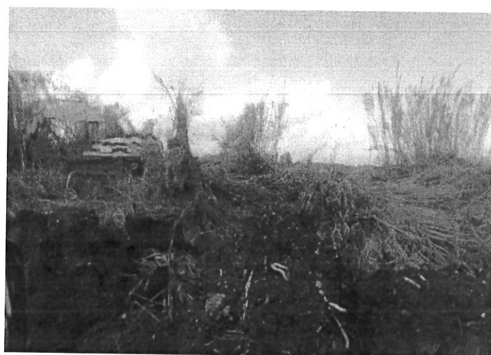
Καθαρισμός καναλιού Μουτελάκη
